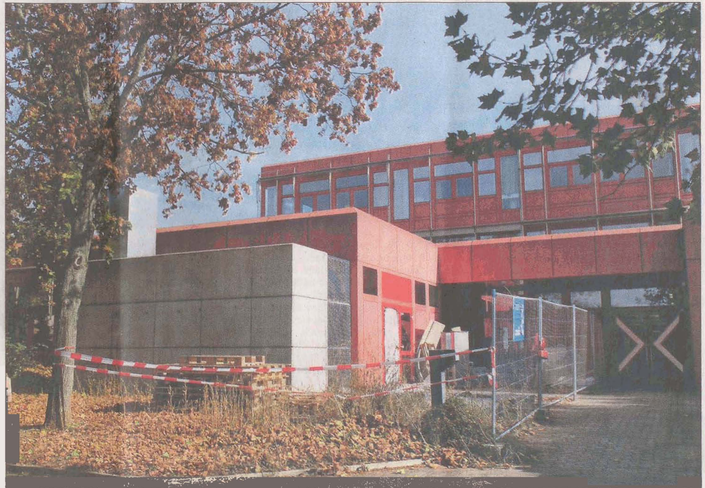
Die Ludwig-Uhland-Schule wird künftig Werkrealschule mit Ganztagsbetrieb. Dafür wird die Schule seit geraumer Zeit umgebaut.
