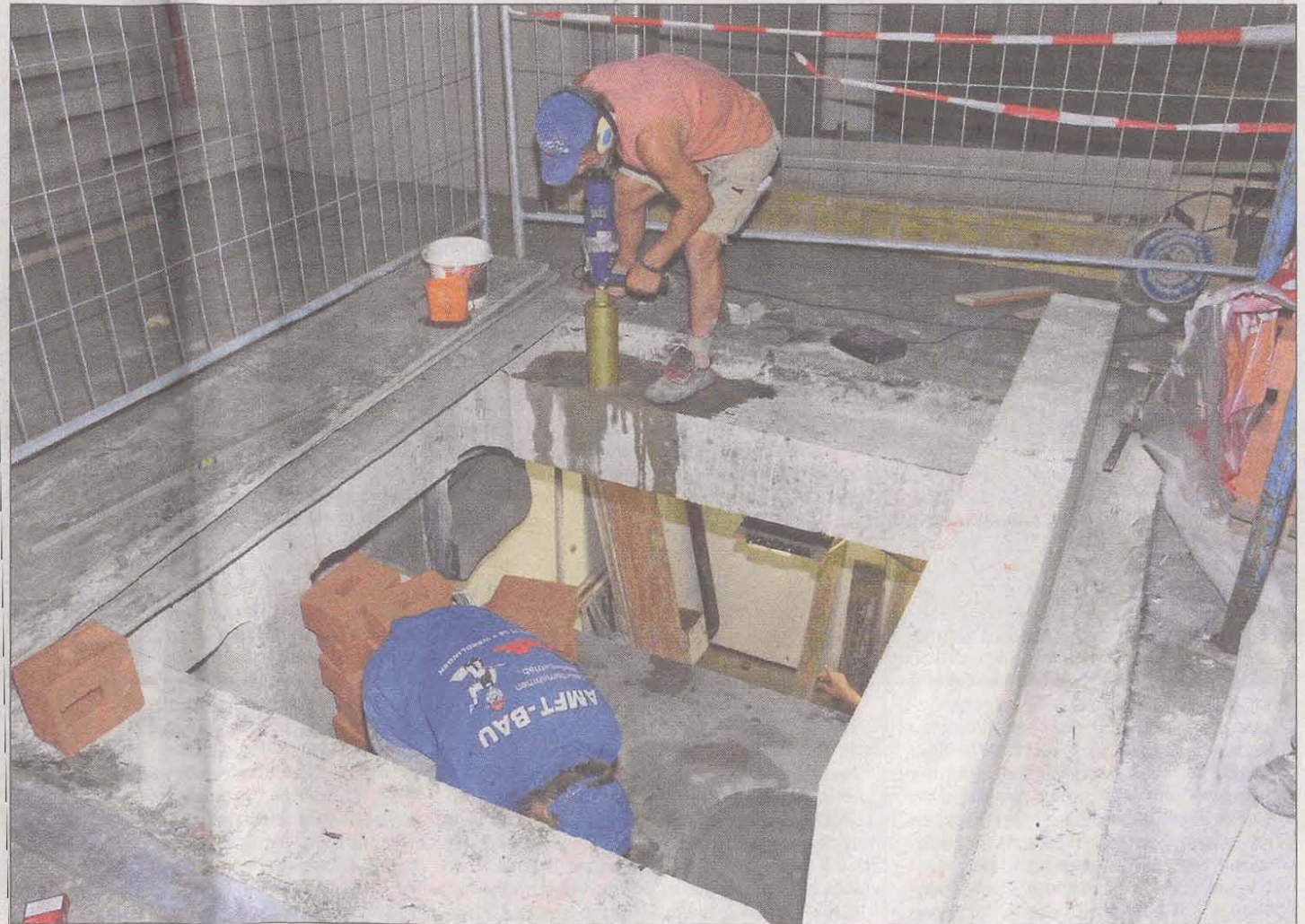
Der Aufzugsschacht in der Ludwig-Uhland-Schule ist ausgesägt, jetzt werden die Schachtwände zugemauert. In den Herbstferien wird die Aufzugstechnik eingebaut.
