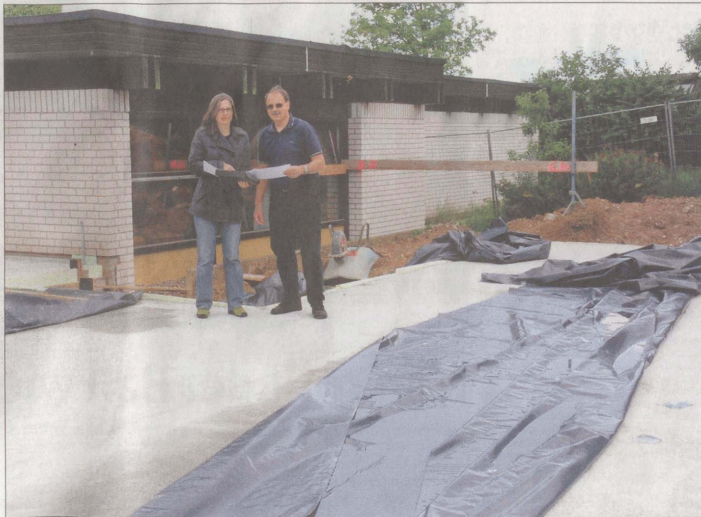
Die beauftragte Architektin Susanne Essig und Stadtbaumeister Paul Herbrand bei der Begehung der Baustelle in der Hebelstraße.
